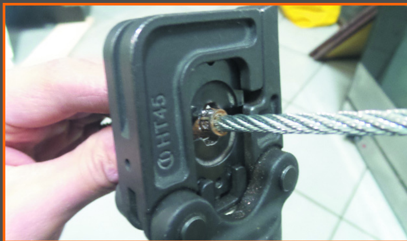
Fig.8 Compressione di un morsetto di giunzione sul cavo eseguendo una doppia pressata in uno stesso punto del morsetto ruotandolo di 90 gradi (operazione eseguita in 4 punti della giunzione) per l'esecuzione di prove di rottura a trazione Compression of a junction clamp on the cable by performing a double pressing in the same point of the clamp, and rotating it by 90 degrees, to perform tensile breaking tests
