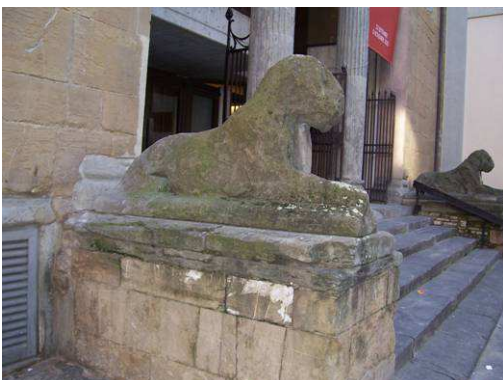
Leone scolpito in Pietra Serena di fronte alla ex Chiesa di San Pancrazio. Avanzato stato di degrado - esfoliazione
