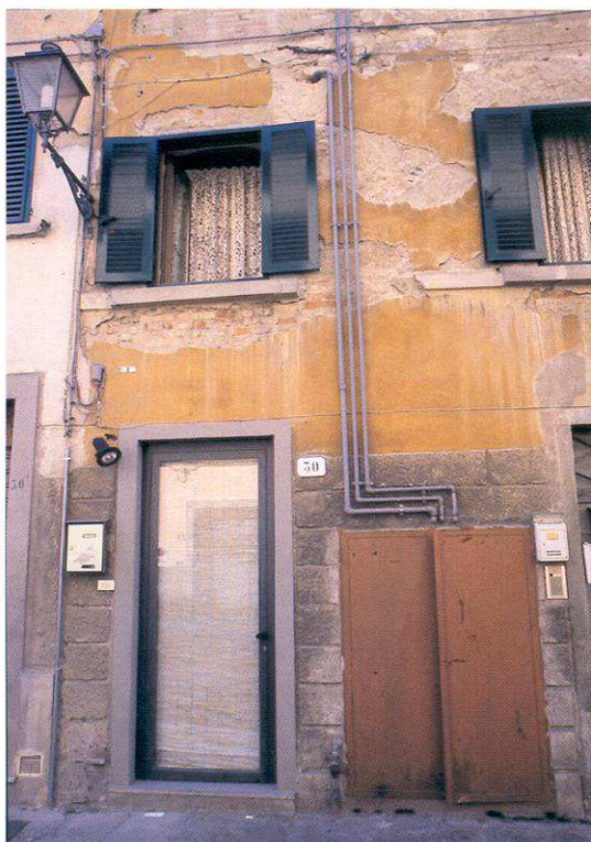
Degrado e interventi incongrui alterano in modo evidente le facciate (casa a schiera in via Calimara, particolari del fronte esterno)
