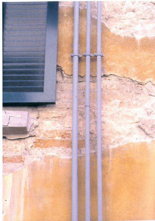
Degrado e interventi incongrui alterano in modo evidente le facciate (casa a schiera in via Calimara, particolari del fronte esterno)
